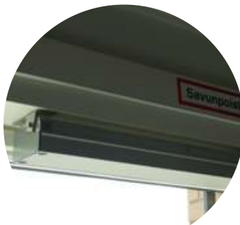
Ketjuavaajalla varustetun savunpoistoikkunan moottori.
